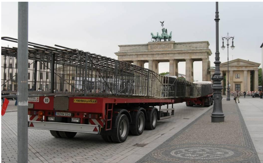
Линия U5 Берлин, Германия, 2007 Армирование в зонах прохождения Микро-ТБМ
